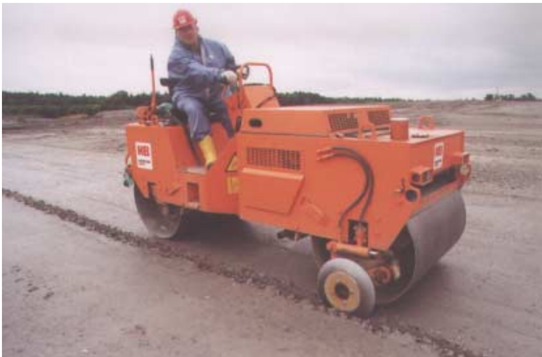
Abbildung 4: Verlegung der MPLE des Systems GEOLOGGER
