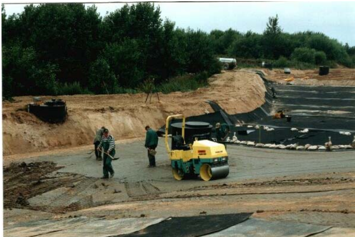
Abb. 6: Mineralische Dichtung und Einbau der Kunststoffdichtungsbahn 2000
