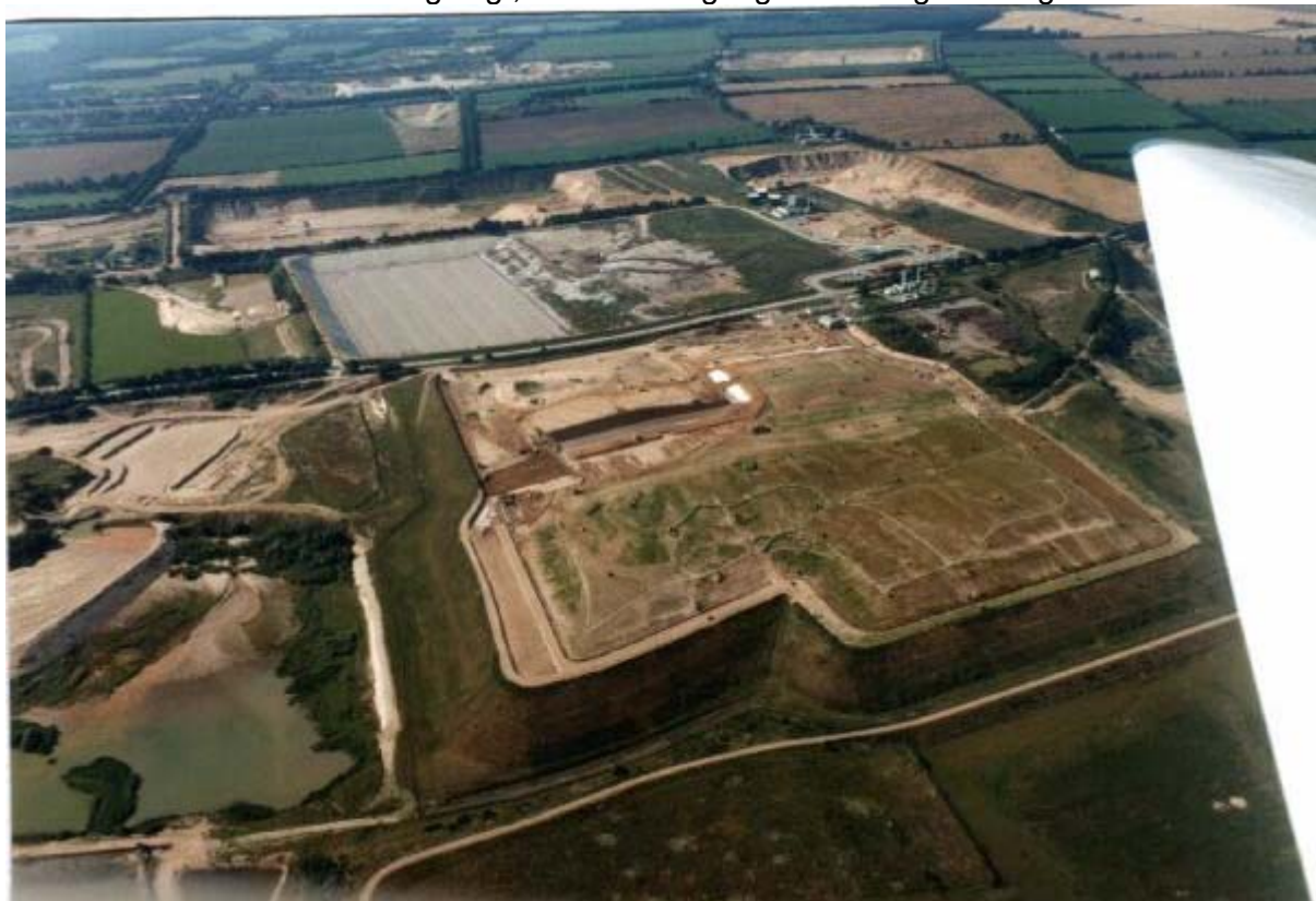
Abb. 1: Zentralmülldeponie Damsdorf/Tensfeld, Kreis Segeberg 1997
