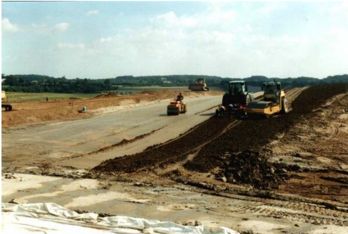
Abb. 4: Einbau der Ausgleichsschicht und der mineralischen Dichtung
