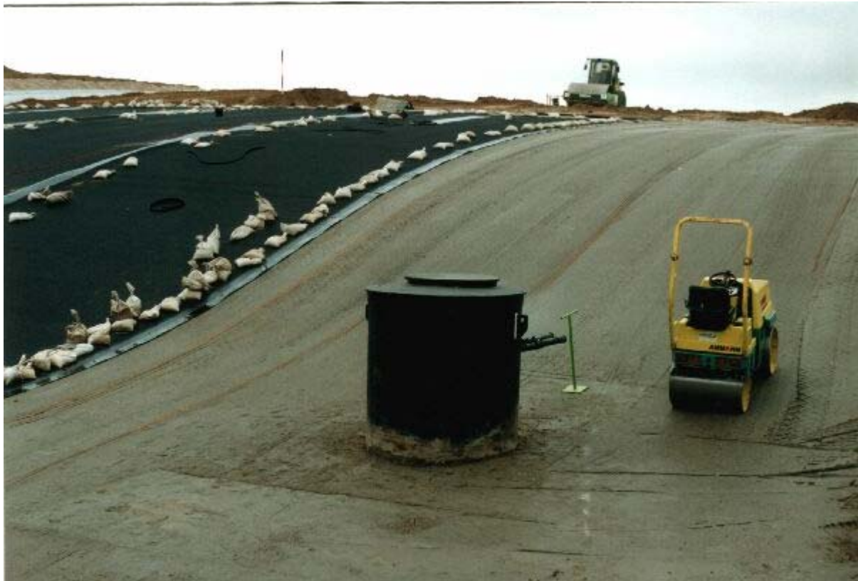
Abb. 5: Mineralische Dichtung und Einbau der Kunststoffdichtungsbahn 1999
