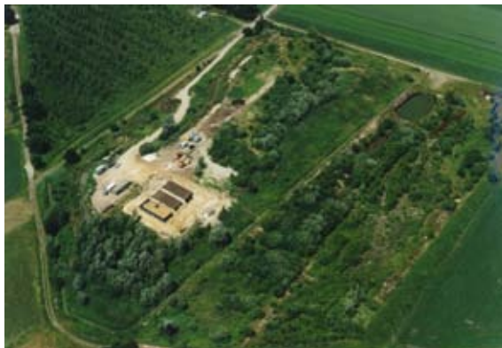
Altdeponie Kuhstedt Anlagen zur aeroben in situ Stabilisierung
