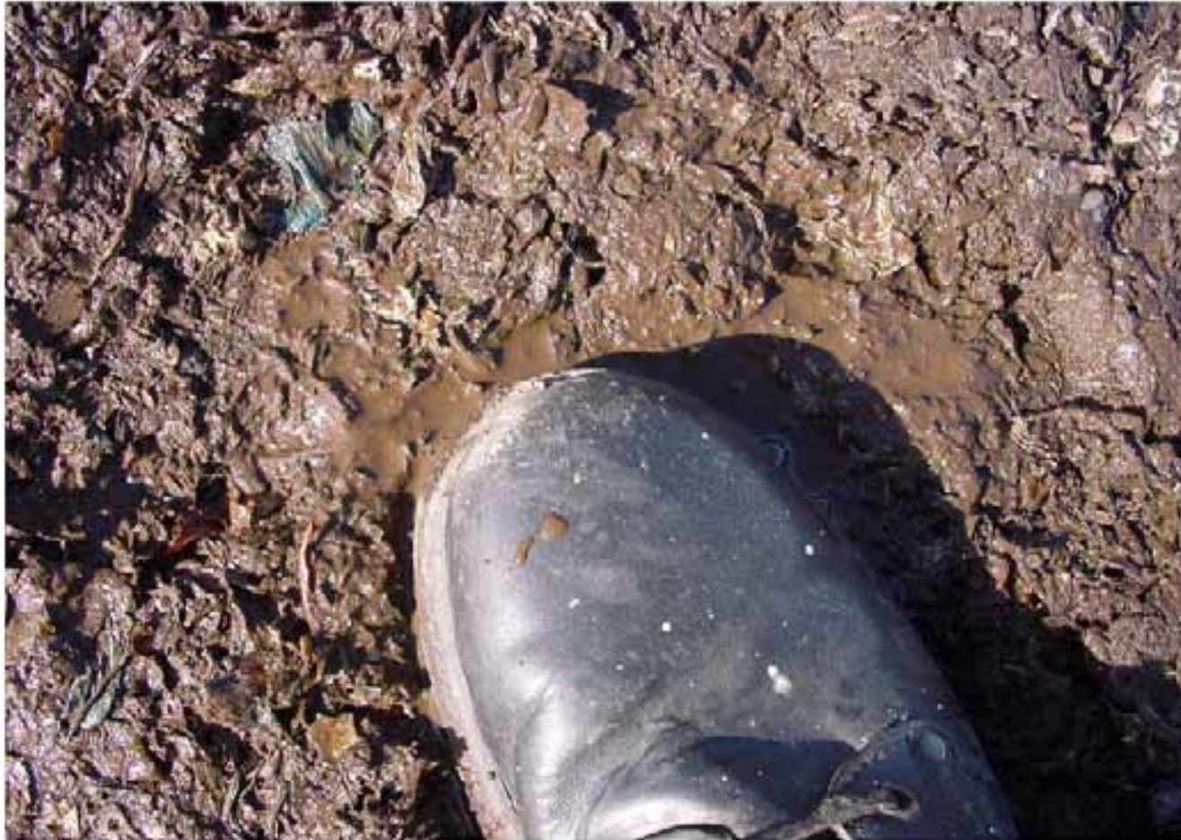
Feuchtigkeit unter der Folie
