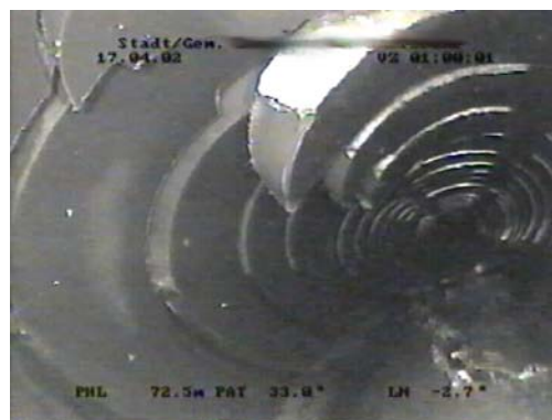
Bilder 8 und 9: Einsturz einer gelochten und einer geschlitzten PE-HD Leitung
