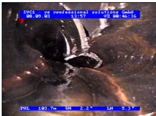
Bilder 8 und 9: Einsturz einer gelochten und einer geschlitzten PE-HD Leitung
