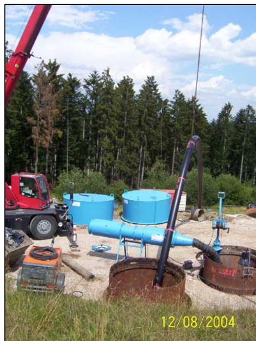
Bilder 12 und 13: Schneidkopf und Baugrube für die Durchführung des PE-HD-Berstverfahrens
