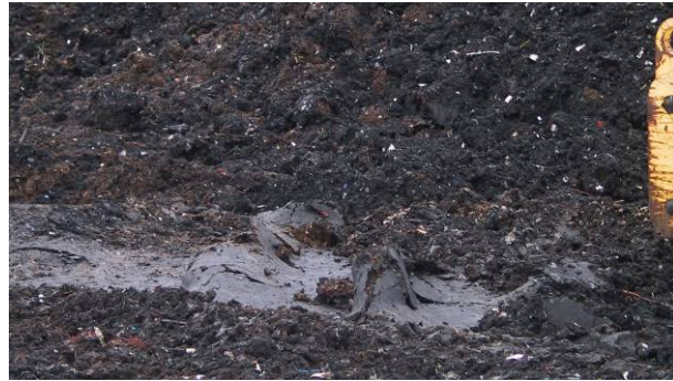
Abbildung 2: vernässte Abfalloberfläche nach Niederschlagsereignis (links), Verdichtung einer stark vernässten Abfalloberfläche (rechts)
