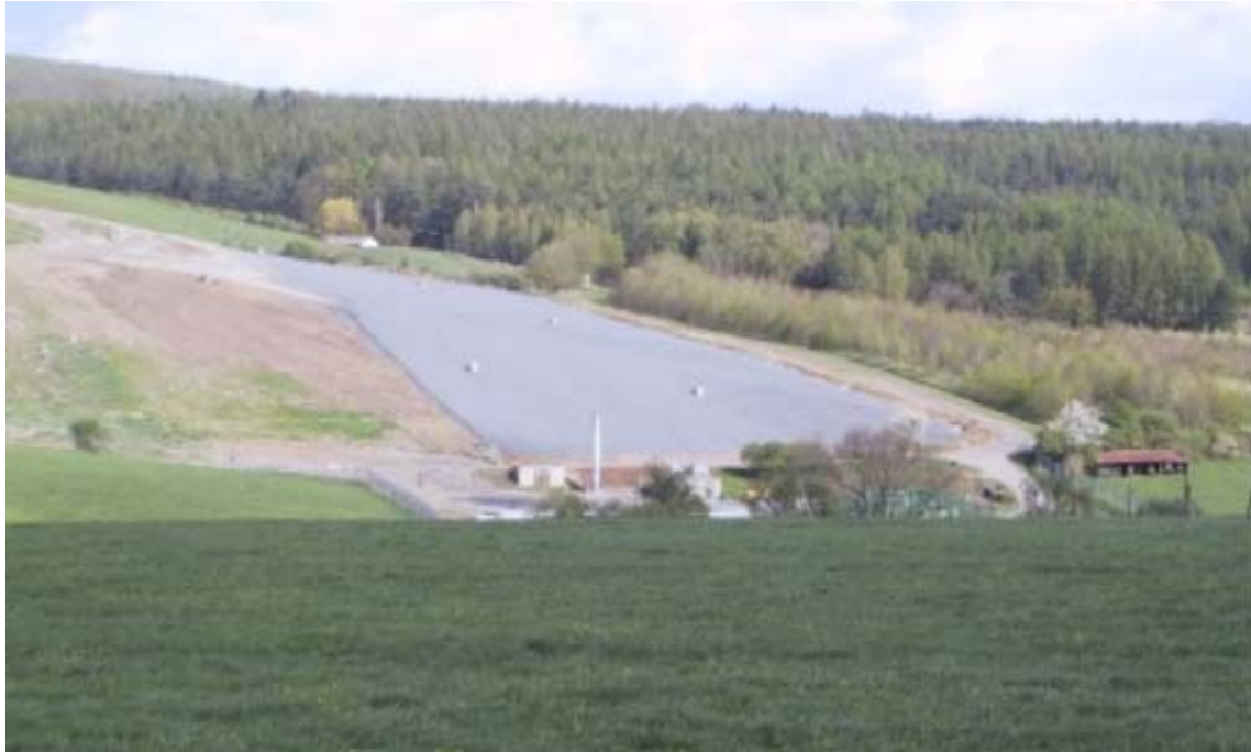
Abb. 1: Fläche mit Gasdrainschicht
