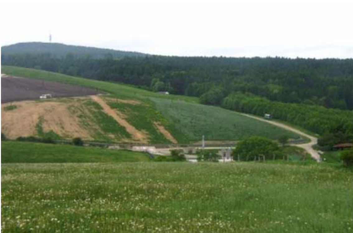
Abb. 2: Fläche nach Aufbringen der Oberflächenabdeckung und Einsaat
