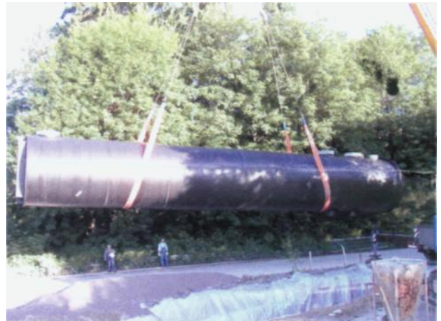
Abladen und Versetzen mit Mobilkran
